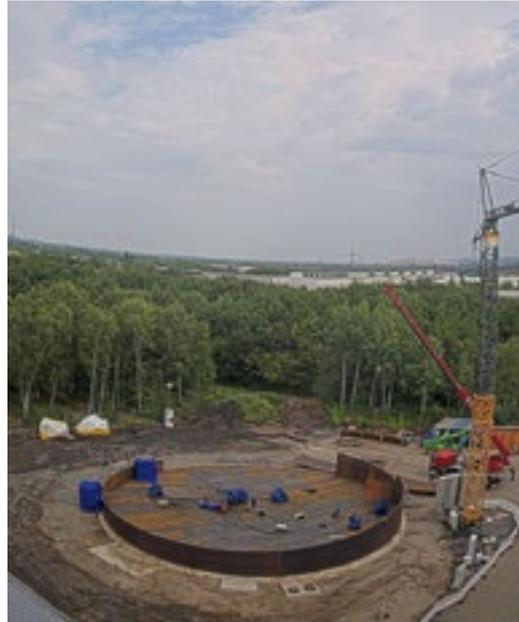
Abbildung 10.14: Neubau eines Fernwärmespeichers, hier am Standort Gelsenkirchen. Quelle: Iqony Fernwärme GmbH
