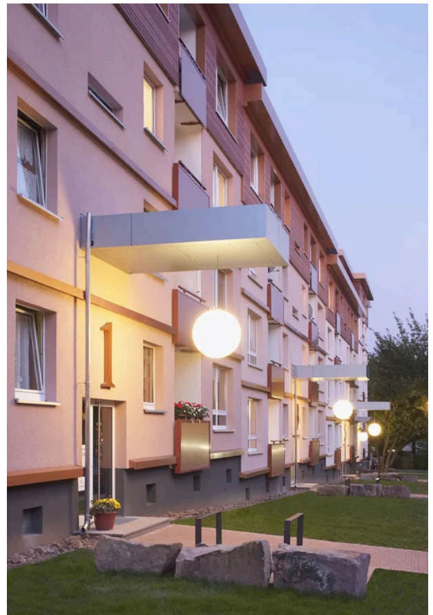
Modernisierte Gebäude Jaspersweg, Foto: Stadtbildplanung Dortmund GmbH, 2008
