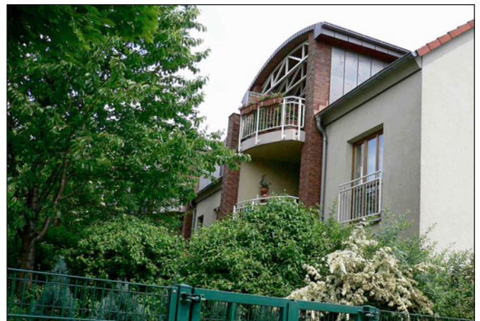
Foto 1: Neu entstandenes Wohngebäude in Essen-Katernberg unter Einbeziehung von Qualifizierungsmaßnahmen
