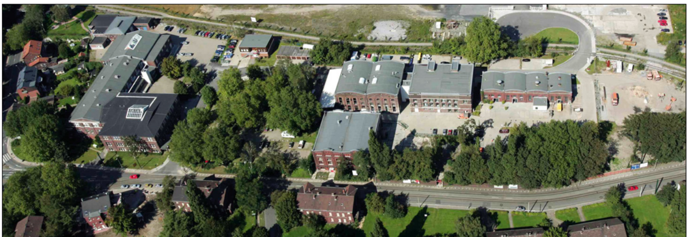
Umgebaute Zeche Zollverein mit dem Zentrum für kleine und mittlere Unternehmen Triple Z AG
