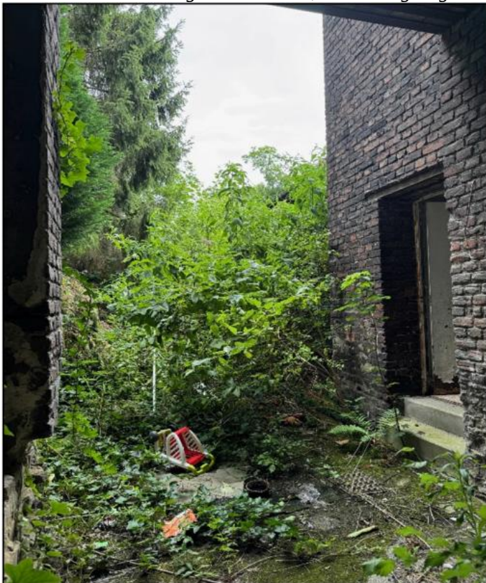
Zufahrt zu rückwärtigem Gelände (vollständig zugewachsen)
