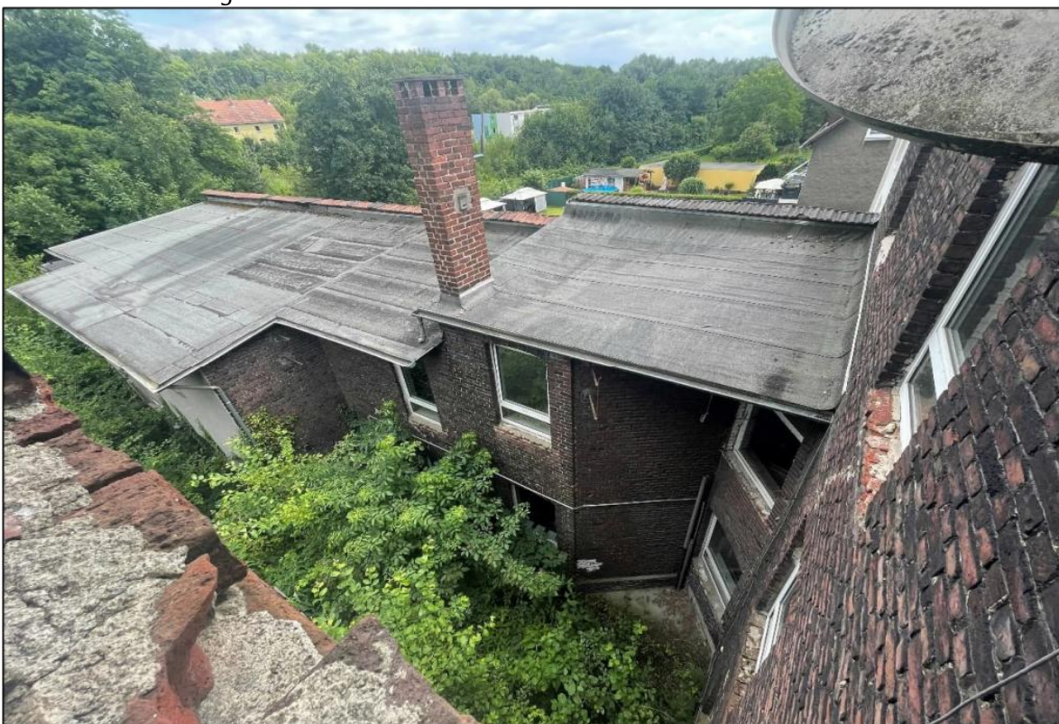
Blick auf rückwärtiges Gebäude
