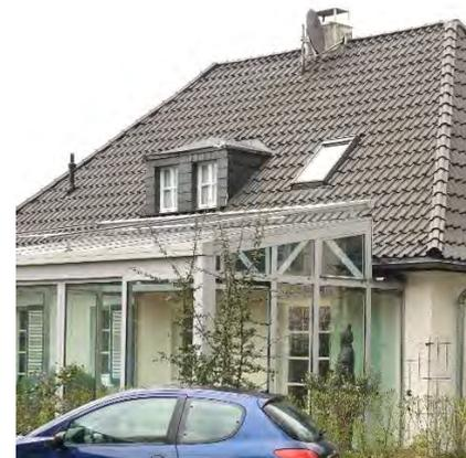
Ein Wintergarten mit Erhalt der Gebäudefassade ist additiv und reversibel. Der Ausgang erfolgt über eine Fenstertür. Analog ist eine entsprechende Fassadenöffnung ohne Einbau der Holz-Glas-Tür möglich.
