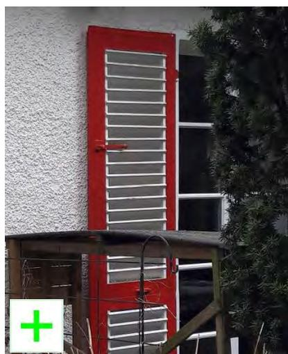
Originaler Blindladen der Bauphase III mit ergänztem Element, das an den ursprünglichen Blindladen gekoppelt ist. Fotos UDB 2018
