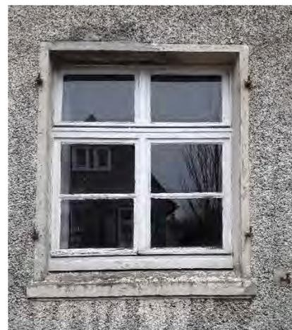
Ursprüngliches Fenster der Bauphase III (1937-38), in originaler Bauform erhalten.
