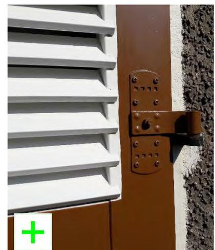
Zeitgenössischer, erneuerter Blendladen. Ausführung analog zu den ursprünglichen Blendrahmen mit vereinfachten Beschlägen. Putzausbesserungen sollen jedoch farblich angepasst werden. Fotos UDB 2016
