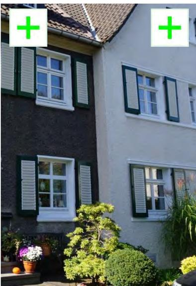
Fassadenoberflächen von 1937, Bauphase III, links unbehandelt, rechts mineralisch beschichtet. Foto UDB 2016
