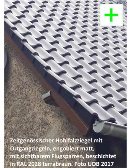
Zeitgenössischer Hohlfalzziegel mit Ortgangziegeln, engobiert matt, mit sichtbarem Flugsparren, beschichtet in RAL 2028 terrabraun. Foto UDB 2017
