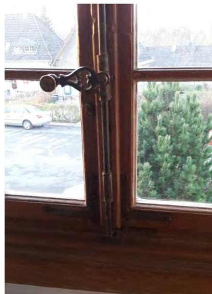
Originales Fenster von 1911, Bauphase I, Drehstangenverschuß mit Vorreiber, Foto UDB 2017
