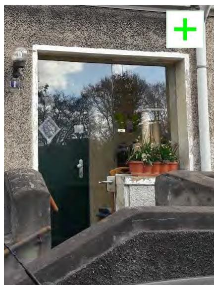
Auch bei einem direkten Anschluss einer Tür an eine Festverglasung ist eine rahmenlose Ausführung möglich. Foto UDB 2017
