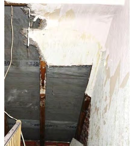
Ursprüngliche Bekleidung der Dachschrägen mit zementgebundenen Holzwoolplatten (Sauerkrautplatten), BP III
