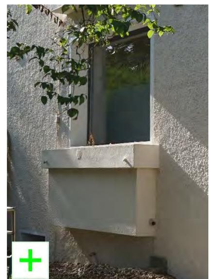
Vorbildlicher Verschluss einer Loggia. Mit einer Ganzglasanlage. Die Strukturfolie entspricht nicht den Leitfäden! Foto UDB 2017
