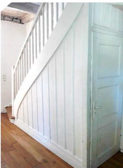
Originale Treppe zum Obergeschoß in BP I (1907-11) mit Holzwand zur Abtrennung des Kellerraumes, Foto UDB 2018
