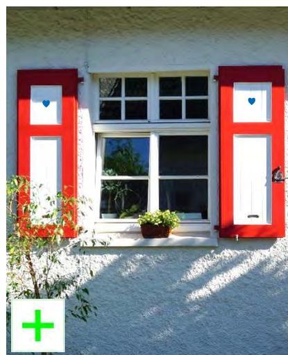
Erneuerter Blendrahmen, Aufbau mit Rahmen und Hinterlegung korrekt. Höhe der mittleren Rahmenteilung passend zum Fenster Typ A. Foto UDB 2016
