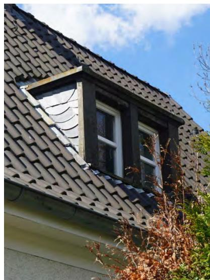
Zweiergaube auf dem Dach einer Einheit, hier ist ein Umbau zum 2. Fluchtweg möglich. Die Sprossenteilung ist hier falsch.
