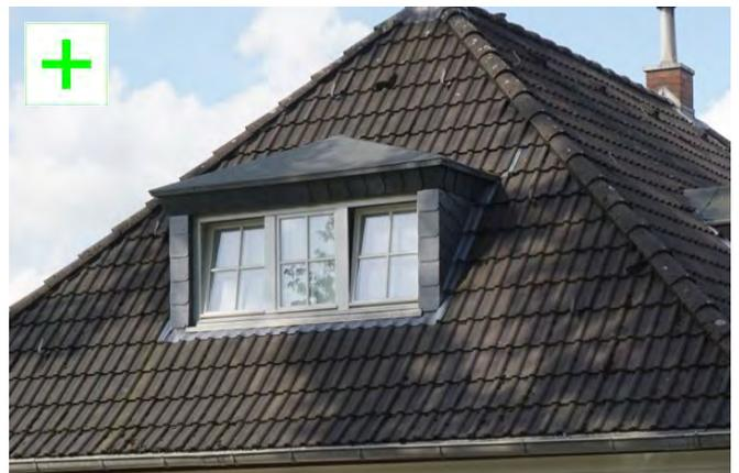
„Dreiergaube“, die zur Herstellung des zweiten Flucht- und Rettungswegs mit vergleichsweise geringen Veränderungen auskommt = Entfall der Pfosten.
