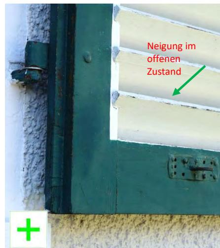
Originaler Blendladen der Bauphase III im Detail, Lamellen hier eingelassen in Rahmenholz. Der Verschluss mit Schnapper konnte mit einer Schnur von innen aufgezogen werden.
