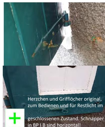
Originaler Blendladen der ersten Bauphase (I B) im Detail, Bandscharnier und Verschluss sind von 1910. Der Verschluss mit Schnapper konnte mit einer Schnur von innen aufgezogen werden. Fotos UDB 2016
