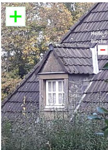
Satteldachgaube mit verputzter Gaubenfront. Deckung und Bleche wurden erneuert, Foto UDB 2017
