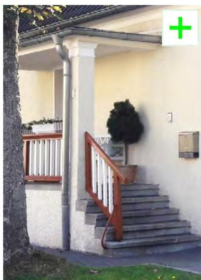
Originale Eingangsüberdachung mit ursprünglicher Treppe. Rinne und Fallrohr sind neu. Eichhoffweg 1, Foto UDB 2017
