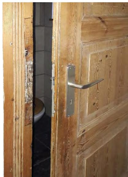
Ursprünglicher Türrahmen mit Falle aus Bauphase I, abgebeizt, ursprünglich geölt, Foto UDB
