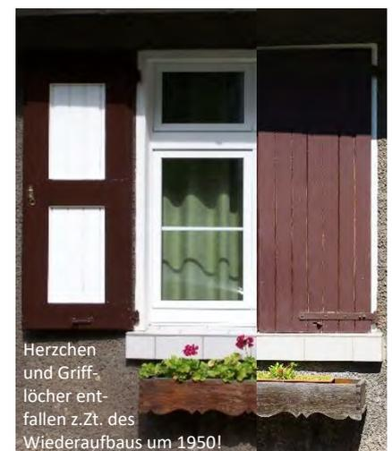
Erneuertes Blendrahmen aus der Zeit nach dem 2. Weltkrieg an einem **Wiederaufbau**. Ausführung analog zu den ursprünglichen Blendrahmen, jedoch ohne Griffloch und Herzchen. Fotos UDB 2016
