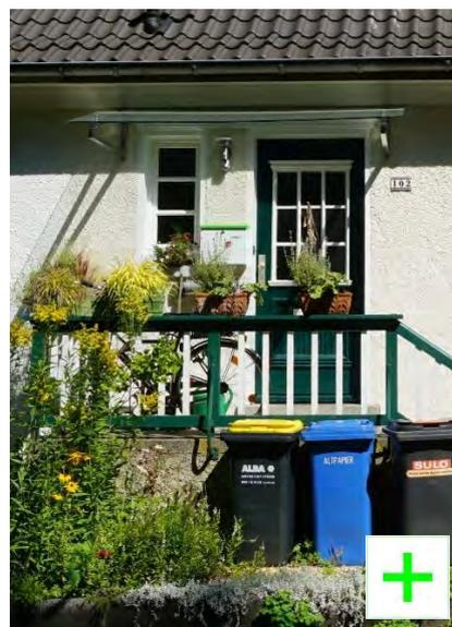
Hauseingang mit originaler Treppe und Vordach aus Glas mit Metallhalterung, Foto UDB 2017
