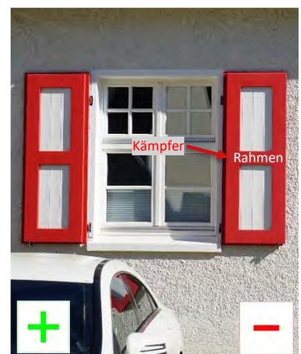
Erneuerter Blendrahmen, Aufbau mit Rahmen und Hinterlegung korrekt. Höhe der mittleren Rahmenteilung nicht passend zum Fenster Typ A. Dieser Blendladen hätte zu Fenster Typ B in Bauphase I B gepasst. Foto UDB 2016
