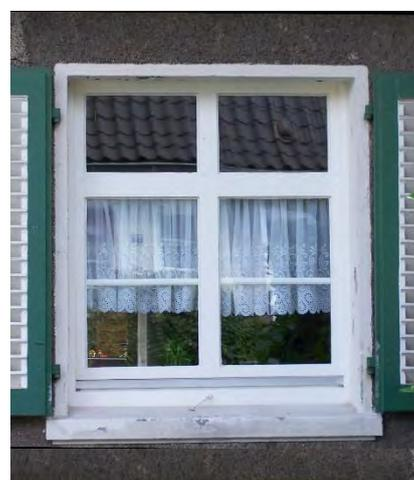
Saniertes Fenster Bauphase III in vereinfachter Bauform: Einflügelig, hier in Holz und teils in Kunststoff, eingebaut von Fa. Krupp.
