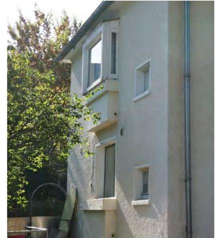
Loggiaverschlüsse in zwei Varianten an einem Mehrfamilienhaus, unten mit Ganzglasanlage. Foto UDB 2016
