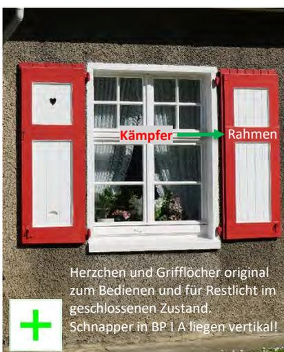
Originaler Blendladen der ersten Bauphase (I A) Passend zu Fenster Typ A, mittleres Rahmenholz mit Bezug zum Kämpfer des Fensters. Kassettenflächen außen sichtbar im geöffneten Zustand. Foto UDB 2016
