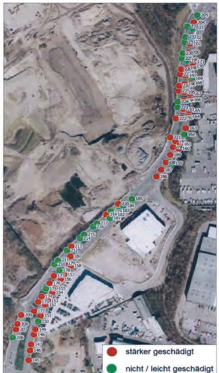
Abb. 7: Zustand der Bäume im Bereich Pferdebahnstraße - Bottroper Straße
