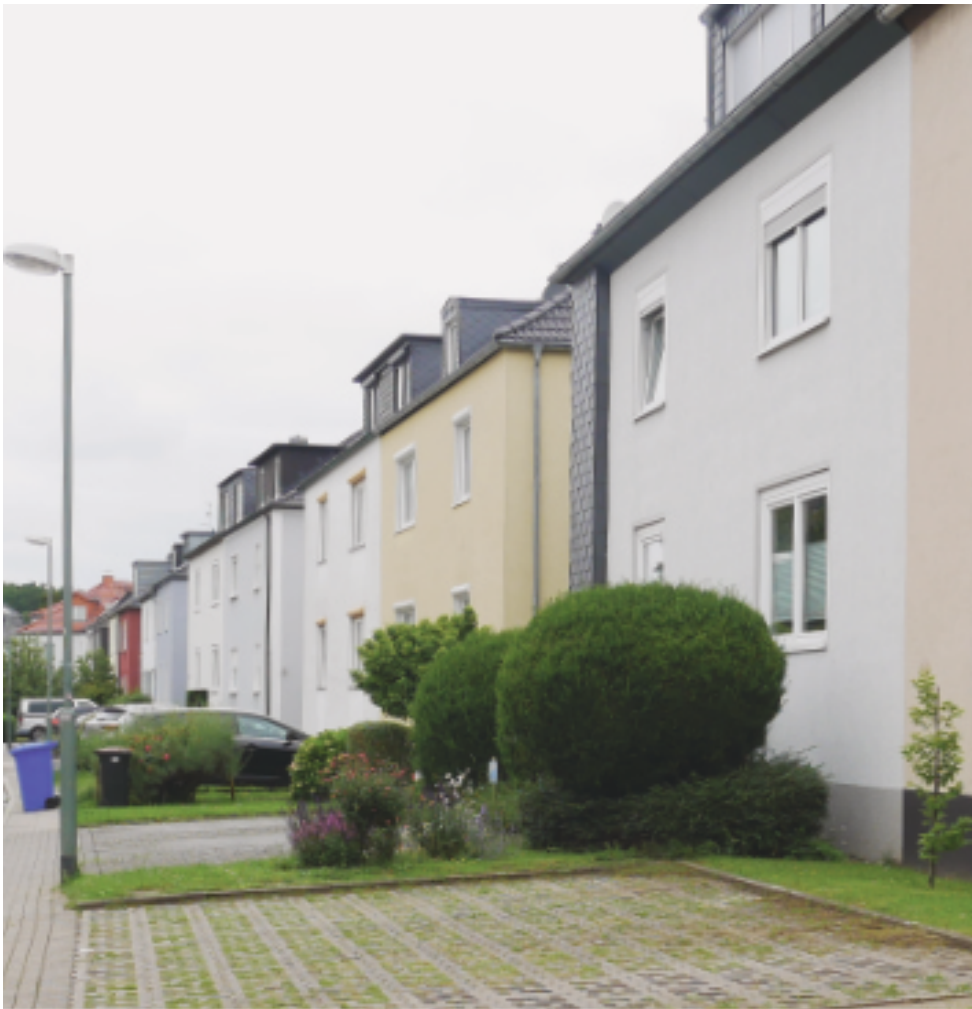
◀ Die Straße Waldsaum mit Doppelhäusern in offener Bauweise , großen Vorbereichen und einheitlichen Bauflüchten .
