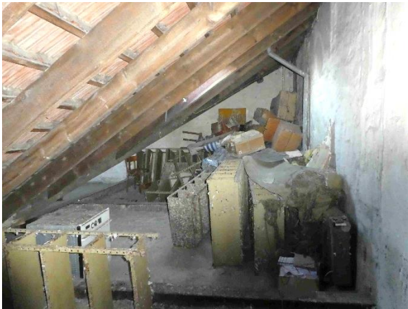
Foto 58: Blick in den bis dahin nicht einsehbaren Bereich (vgl. Foto 29) (Fenster wurden geschlossen)
