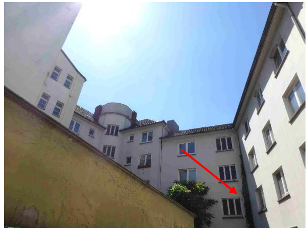
Foto 34: ... mit geringem Fassadenbewuchs ...
