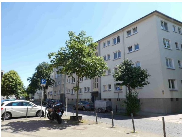
Foto 5: betroffene Wohnbebauung an der Kastanienallee ...
