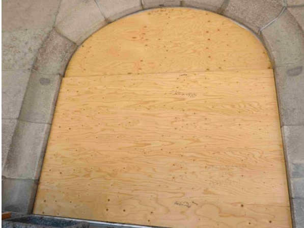
Foto 13: spaltenfreie Verdeckung mittels Bretter der Fensteröffnungen im EG von außen ...
