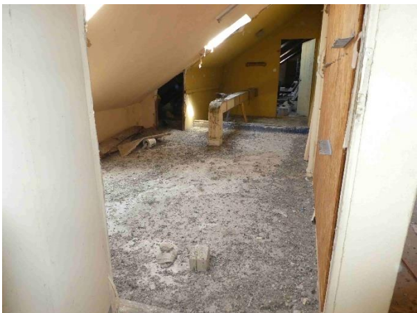
Foto 29: ... und ausgebautem Bereich; hier (sehr wahrscheinlich) geöffnetes Dachfenster -> Taubeneinflug (Boden mit Taubenkot bedeckt)
