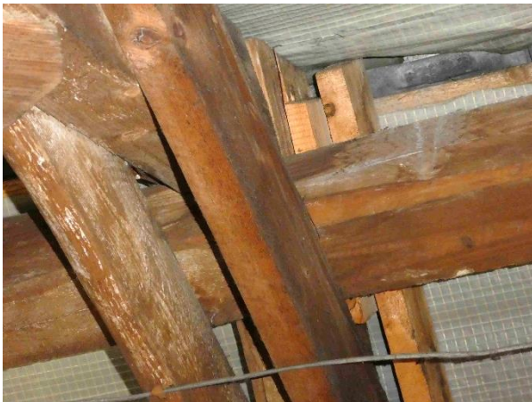
Foto 45: am Gebälk (hier Firstzangen) potentielle Hangmöglichkeiten für Fledermäuse
