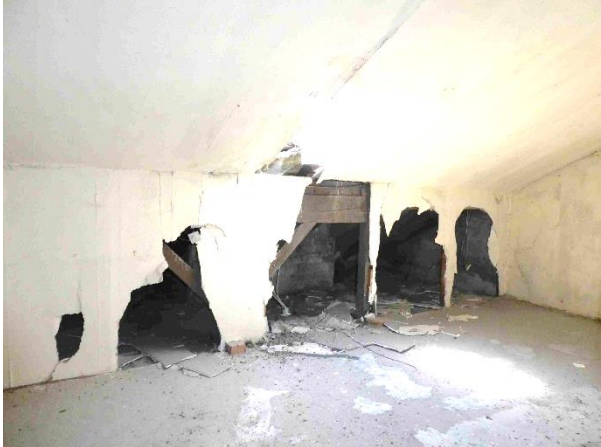
Foto 25: ausgebauter Bereich mit offenem Drempe, ...
