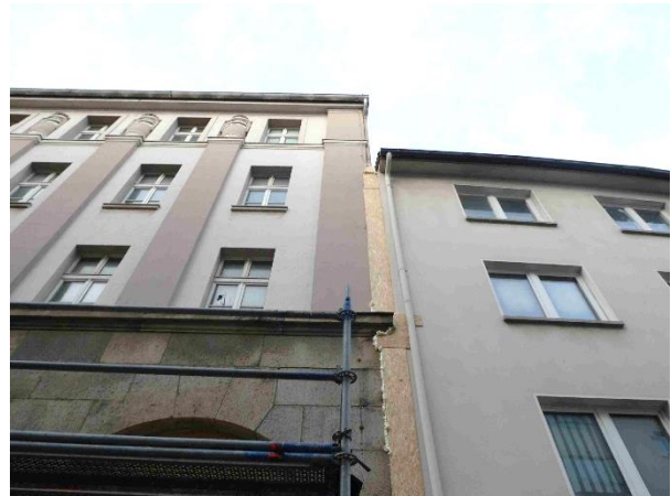
Foto 52:... sowie offene Dehnungsfugen wurden spaltenfrei verschlossen
