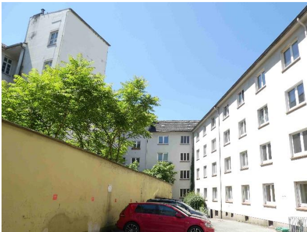
Foto 33: nördliche und westliche innere Gebäudefront ...
