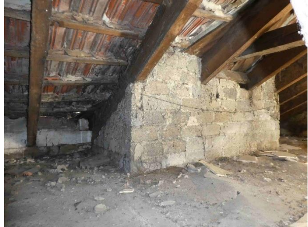
Foto 26: gut einsehbar mit offen liegendem Mauerwerk (ohne Spalten o. ä.)
