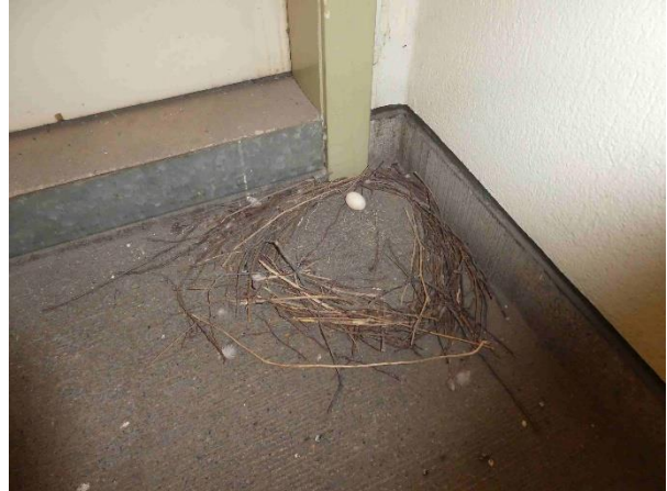
Foto 50: (aktuell unzugängliches) Taubennest vor verschlossener Dachbodentür
