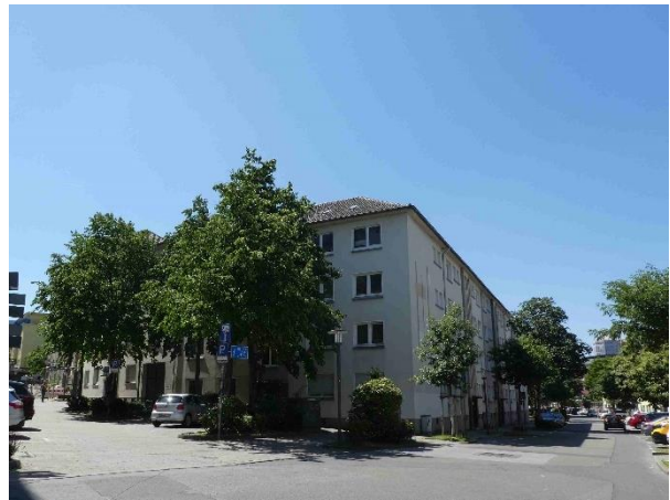
Foto 4: Ecke I. Weberstraße und Kastanienallee mit nahe zu den Gebäuden stehenden Straßenbäumen
