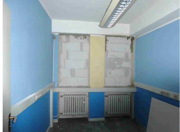
Foto 14: ... und von innen mit Ziegeln
