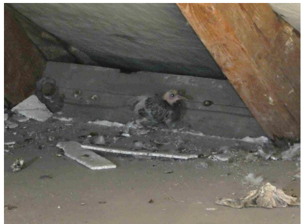
Foto 48: ... entsprechend von Tauben genutzt (Taubenküken)
