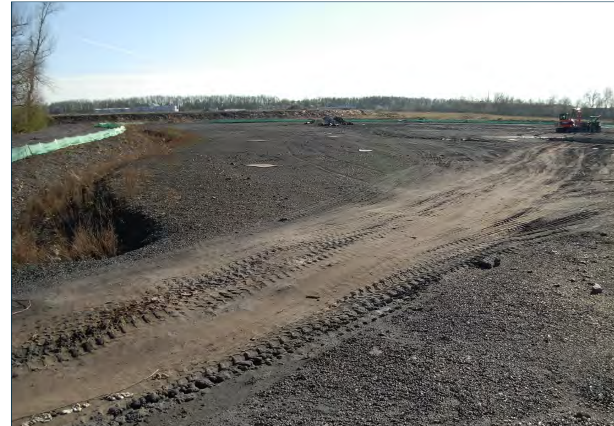
Erdarbeiten und Artenschutzmaßnahmen auf "Emil Emscher"
