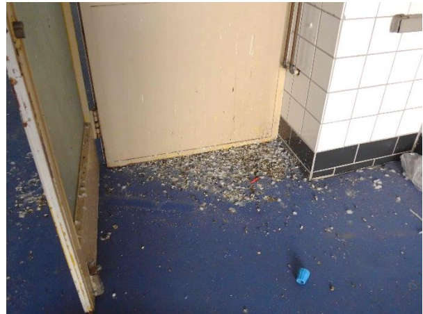
Foto 14: älterer Taubenkot in diesem Raum (Einflug über o. g. Öffnung aber ausgeschlossen)
