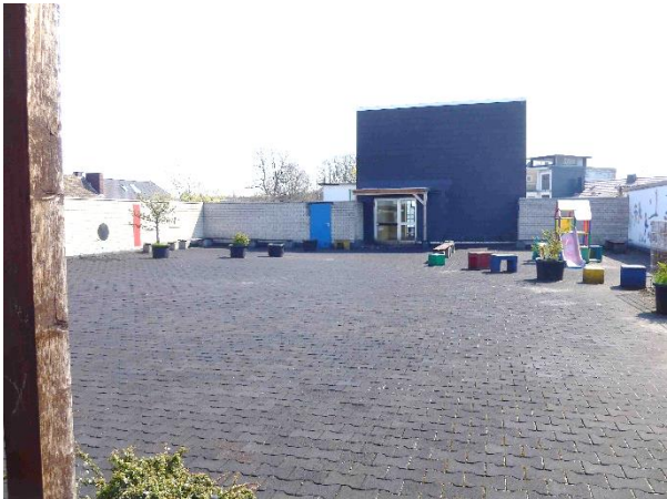
Foto 35: alle Dächer im Plangebiet flach; hier: Außenbereich der KiTa auf dem Dach
