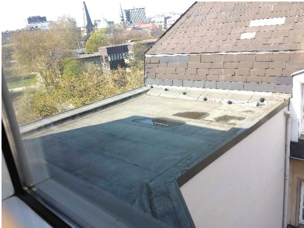
Foto 5: (niedrigerer) Gebäudeteil im Norden mit Anschluss an das Nachbargebäude ...
