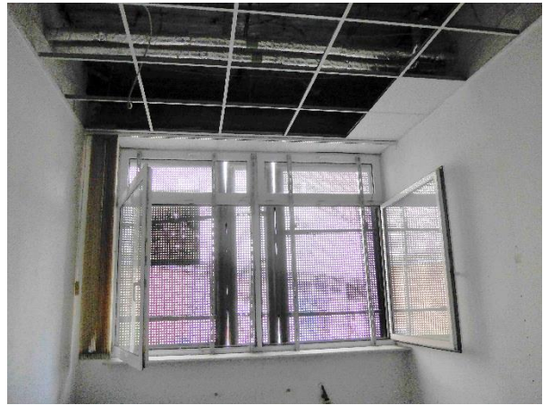
Foto 20: dito: Spalten = Einflugmöglichkeiten (auch über defekten Kippmechanismus auf anderer Gebäudeseite), ...
