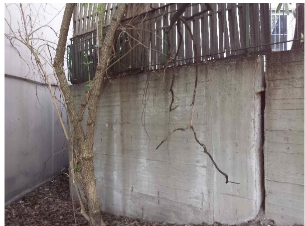
Foto 40: Betonmauer auch am Geländesprung am JobCenter (o. B.)
