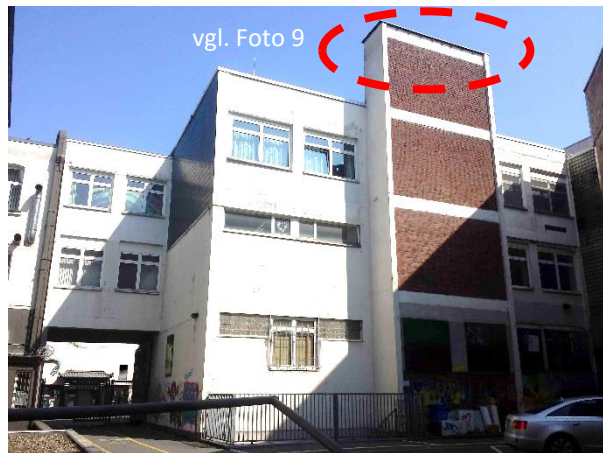
Foto 8: ... Durchgang zur Steeler Str. u. westl. Gebäudeteil des Hauptgebäudes mit ...
