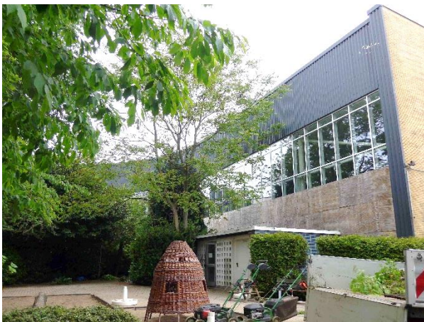
Foto 43: Außenfläche wird von KiTa intensiv genutzt
