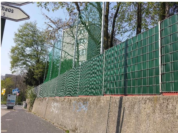
Foto 39: Plangebiet durch (intakte) Betonmauer an der Varnhorststraße abgegrenzt
