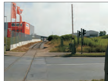
Der künftige Zufahrtsbereich zum TRIMET-Gelände befindet sich rechts vom Anschlussgleis.
