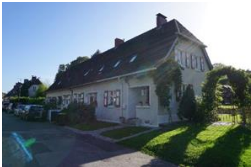
Gebäudeblock der Bauphase I ohne Gauben
