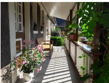
Hausgruppe der Bauphase III mit nachträglich montierter Überdachung
