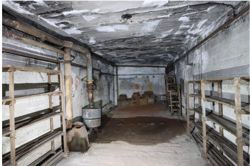
Die Schutzräume verfügten über Heizungen, Gasfilter und Notausgänge
