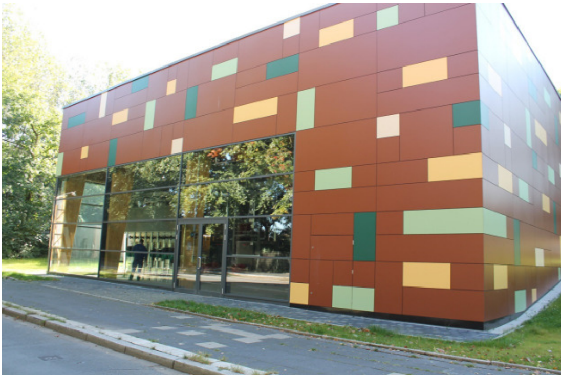
Abb. 7.3: Biomasseheizwerk (Quelle: Essener Versorgungs- und Verkehrsgesellschaft mbH (EVV))
