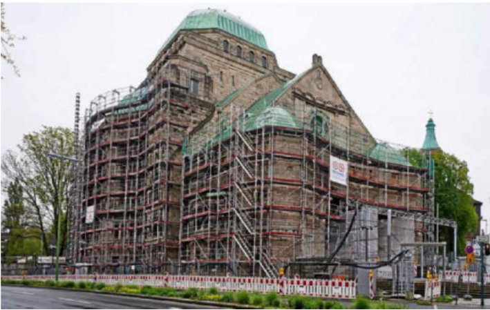
Zu Beginn der Sanierungsarbeiten war das Baugerüst an der Alten Synagoge noch deutlich niedriger. Mittlerweile wurde aufgestockt.
