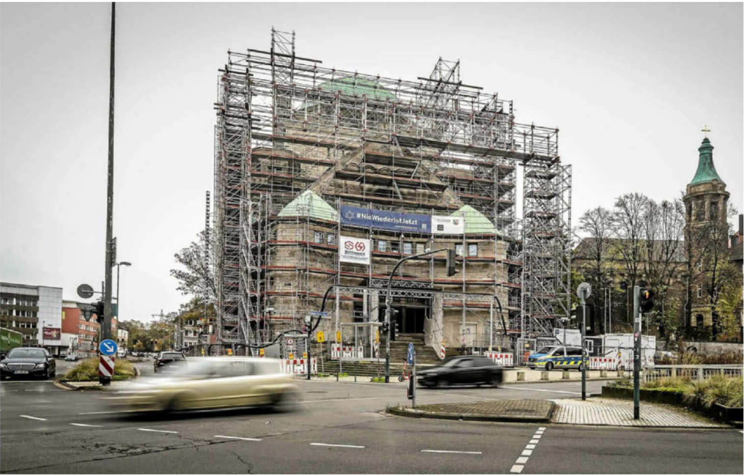
Kein schöner Anblick. Seit rund zweieinhalb Jahren ist die Alte Synagoge eingerüstet und das wird auch noch lange so bleiben. Die Bauarbeiten sollen sich bis Mitte 2027 hinziehen.
