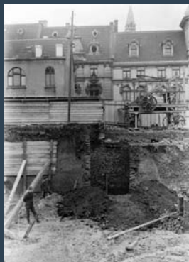
»Runder Turm« (mittelalterliche Kloak) in der Baugrube nördlich Burdeker in der Essener Innenstadt, 1925 (Ruhrlandmuseum Essen, Fotoarchiv)
