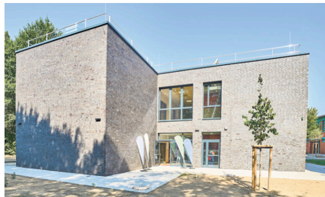
Der Erweiterungsbau am Gymnasium Essen-Überruhr wird bereits seit dem neuen Schuljahr genutzt. Foto: Rosa Lisa Rosenberg, Stadt Essen
