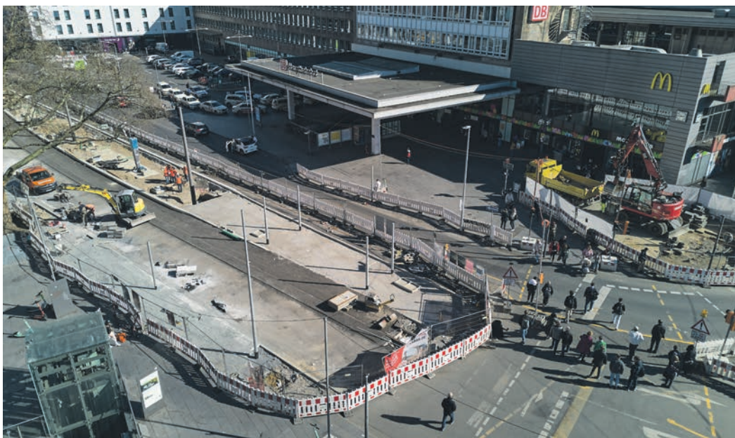
Die Arbeiten auf der Großbaustelle für die CITYBAHN entlang des Essener Hauptbahnhofs, vom Ruhrbahn-Betriebshof bis zur Hans-Böckler-Allee sollen bis Ende des Jahres abgeschlossen sein. Fotos: Moritz Leick, Stadt Essen
