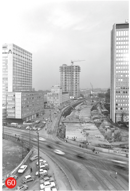
Kruppstraße beim Bau des A40-Tunnels in den 1960er Jahren mit Rheinstahlhaus, Postscheckamt (im Bau) und RWE-Hochhaus (v.l.)
