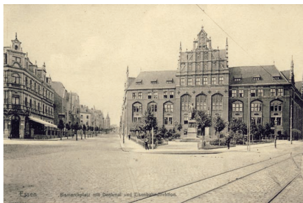
Kaiserzeitlicher Monumentalbau: Reichsbahndirektion vom Bismarckplatz aus um 1900
