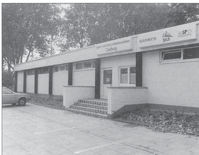
Wozu der alte Umkleidetrakt eines Freibades noch genutzt werden kann ist in Dellwig zu sehen.
