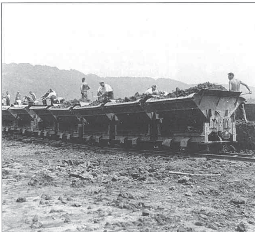
Arbeiter beim Bodenaushub, ca. 1932 (Stadtbildstelle Essen)
