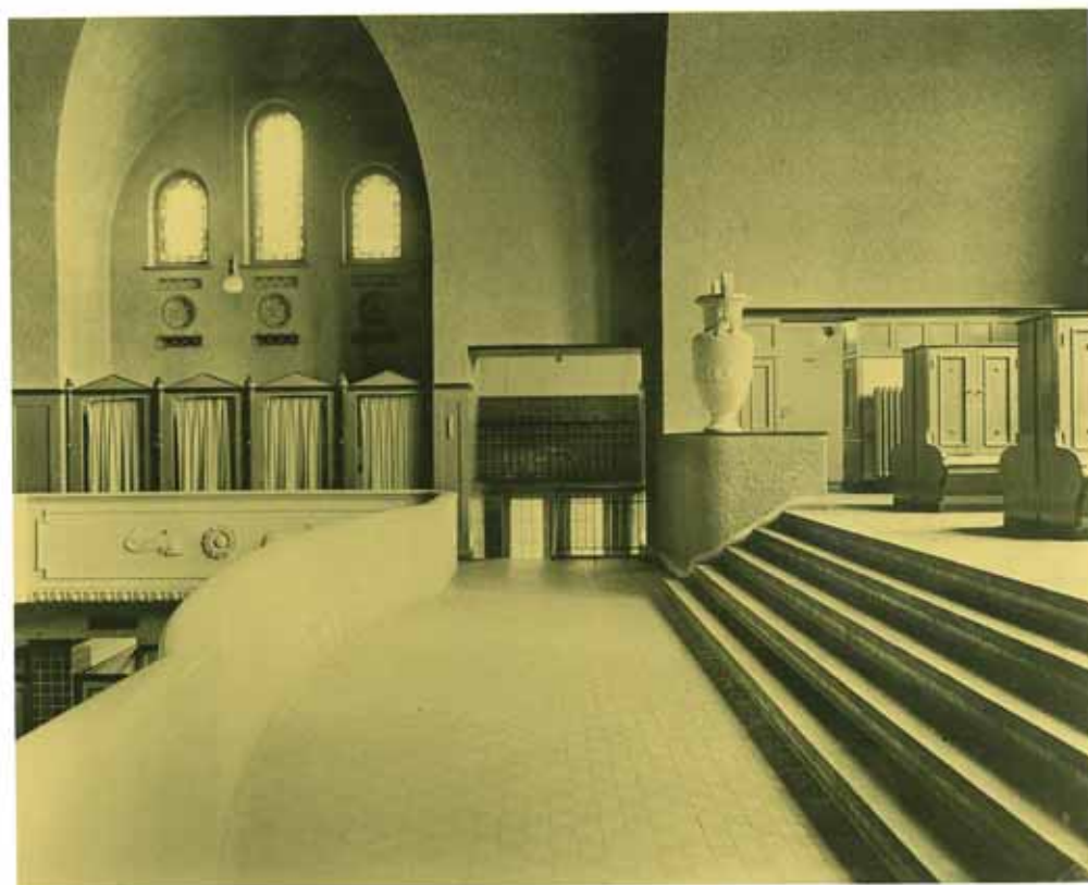
links: Im Obergeschoß der Badeanstalt an der Steeler Straße. Umkleidekabinen vor dem 1914/15 gebauten Damenbad.
