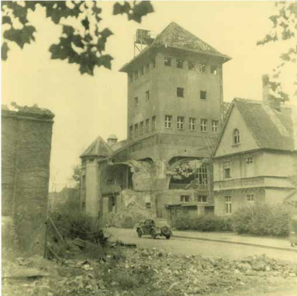
unten: Das zerstörte Friedrichsbad 1945.
