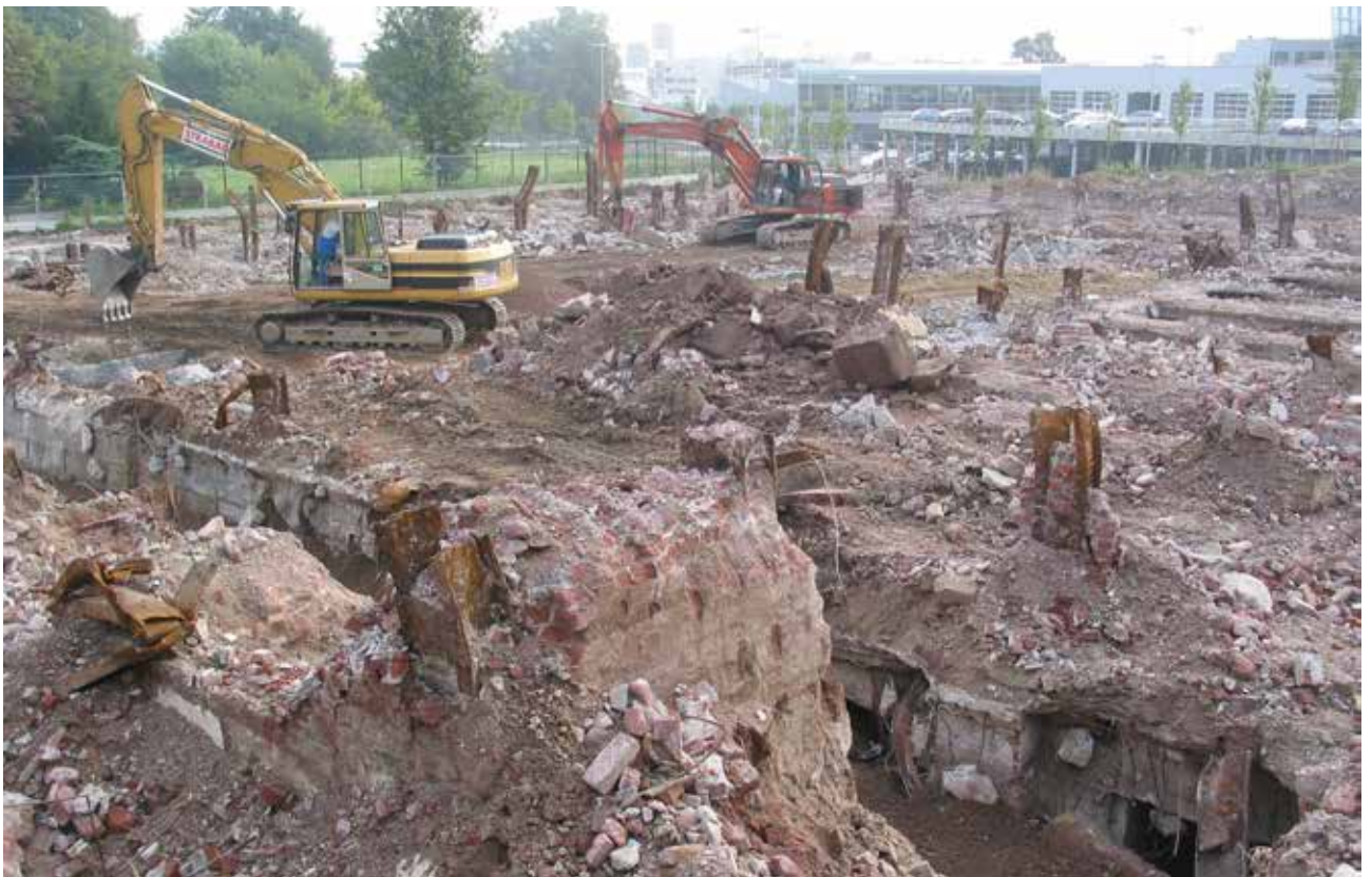
Fundamente der Neuen Hauptverwaltung bei der Freilegung vom Boden aus betrachtet (Foto: D. Hopp)
