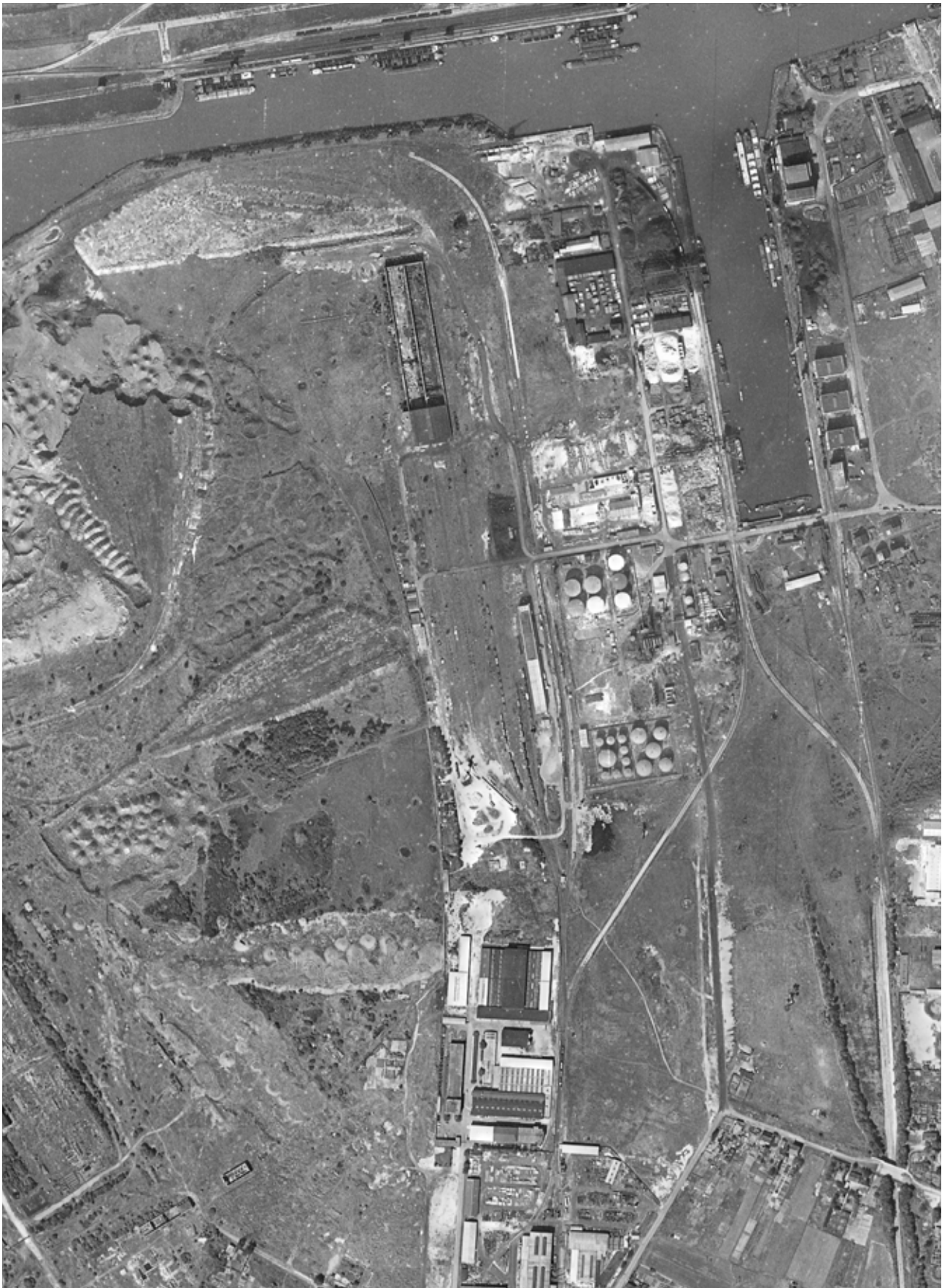
1956 sind auf dem Luftbild, das den Hafen in Vogelheim zeigt, zahlreiche Kriegszerstörungen am Hafen und westlich davon zu sehen. Auf dem Hafengelände wurden Instandsetzungsarbeiten durchgeführt wie zum Beispiel an Öltanks südlich des Hafenbeckens zu erkennen ist. (Foto: Amt für Geoinformation, Vermessung und Kataster)
