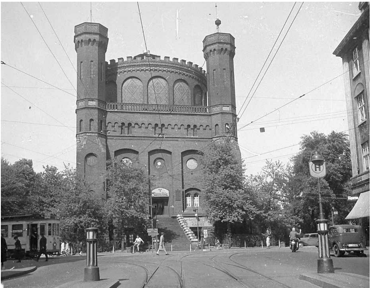
Der Wasserturm am Steeler Berg in den 1920er Jahren (Foto: Amt für Geoinformation, Vermessung und Kataster)
