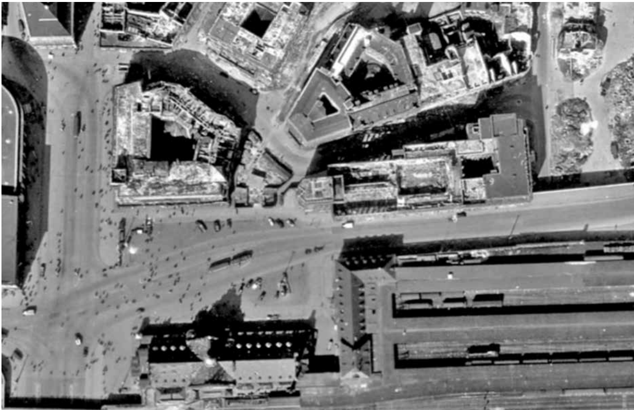
Das Luftbild zeigt den Zustand von 1943: unten am Rand der kaum zerstörte Hauptbahnhof, in der Bildmitte befinden sich der Handelshof und das Haus der Technik. (Foto: Amt für Geoinformation, Vermessung und Kataster)
