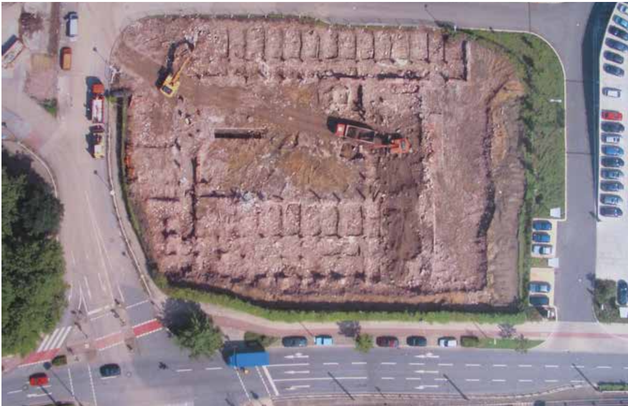
Fundamente der Neuen Hauptverwaltung bei der Freilegung (Foto: D. Hopp)
