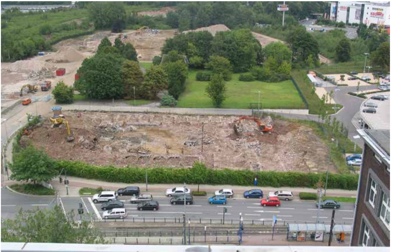
Bauarbeiten im Bereich der Neuen Hauptverwaltung im Jahr 2005, im Hintergrund ist das Stammhaus zu sehen (Foto: D. Hopp)
