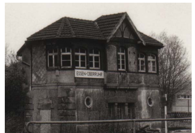
Das alte Stellwerk - Frontansicht
