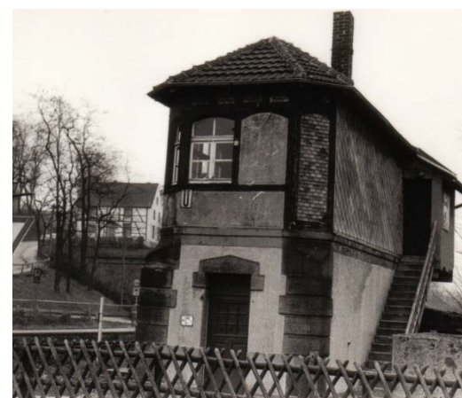
Das alte Stellwerk - Seitenansicht
