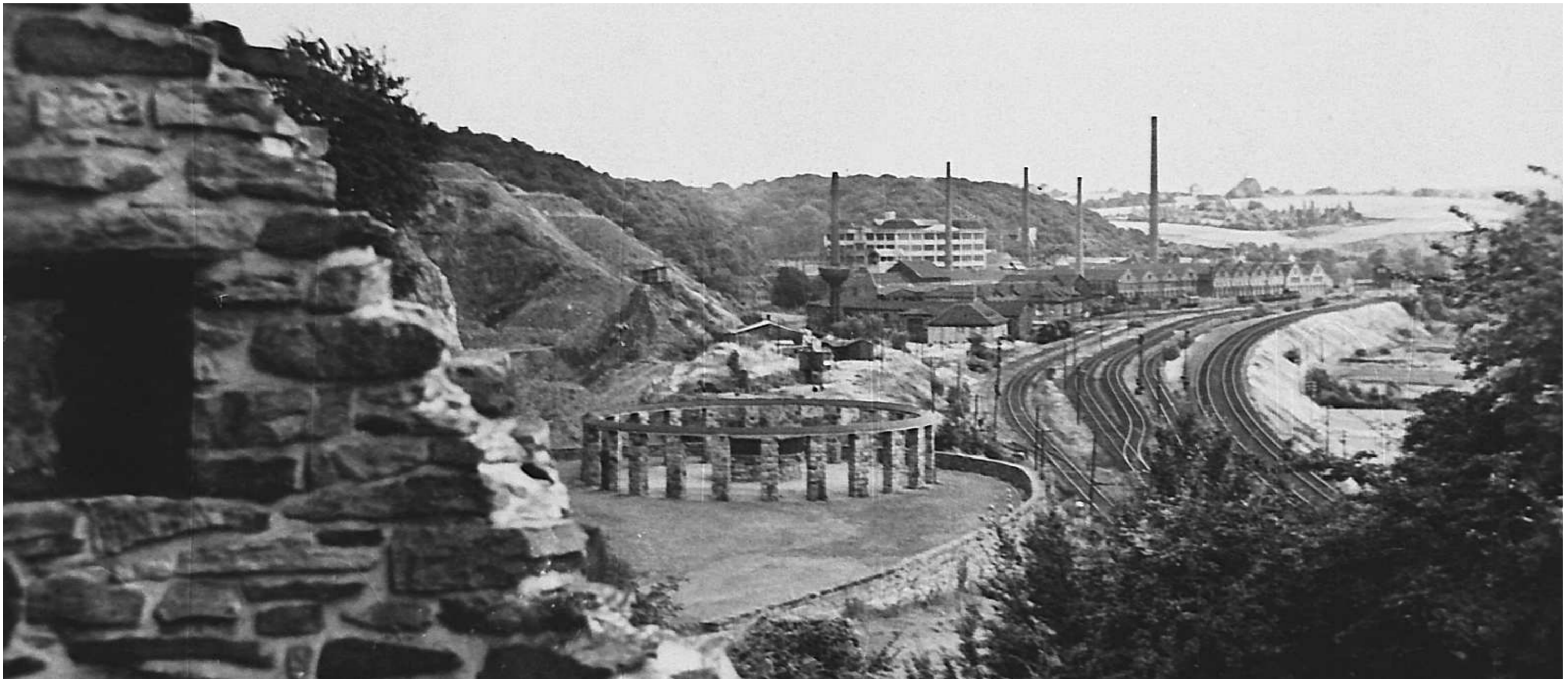
Ansicht von 1940: Blick von Burg Horst auf das Ehrenmal, dahinter Steinbruch Silberkuhle, das Bahnbetriebswerk Bochum-Dahlhausen (späteres Eisenbahnmuseum) und die Fabrik Dr. C. Otto
