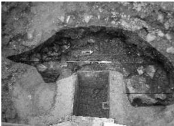
Blick in die Baugrube: Fundamentreste des Viehofer Tores und Kanalschacht, 1995
