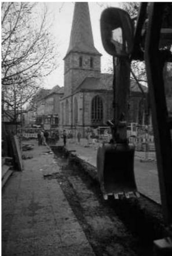
Der Kanalgraben in der Kettwiger Straße, 1992
