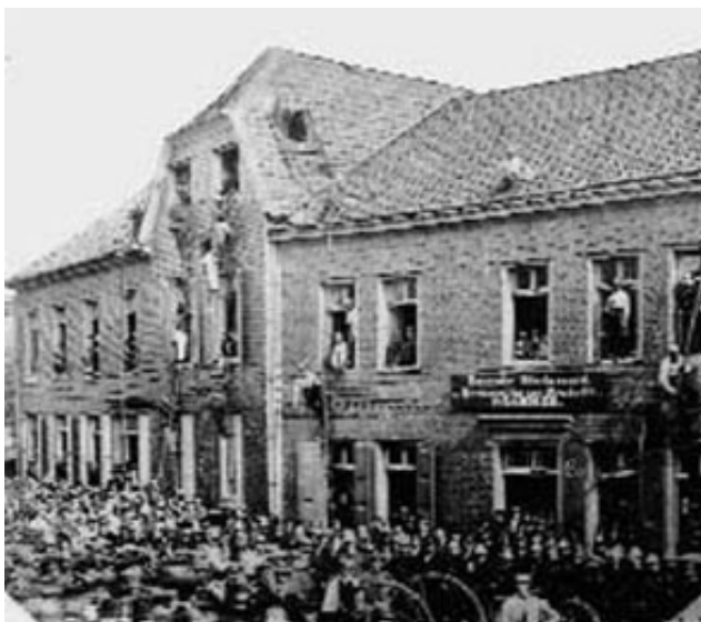
Hospitalsgebäude, kurz vor dem Abriss um 1900
