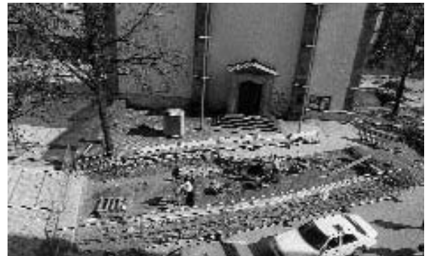
Blick auf die Grabungsfläche, 1995
