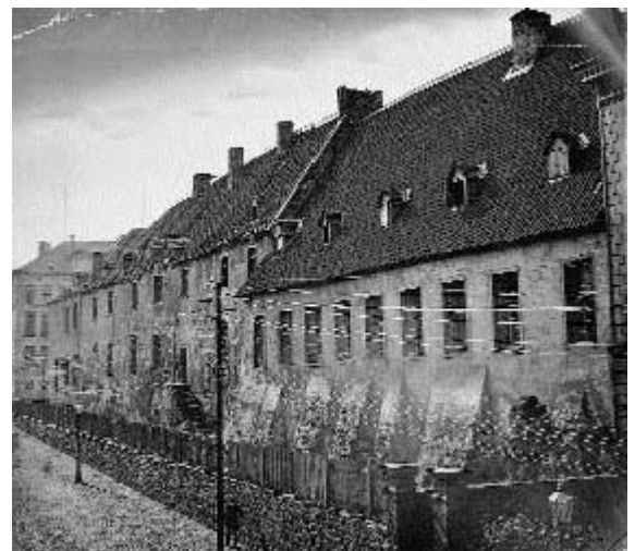
Die Abteigebäude an der Akazienallee vor dem Abbruch, 1883
