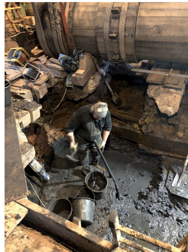
Ausbau der alten Hammersäulen durch die Fa. Perplies Kanalbau, 2020/2021 © Achim Mikuscheit/Ruhr Museum
