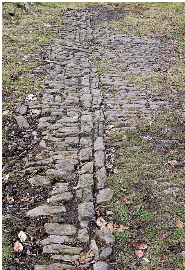
Freigelegte Pflasterreste, 2009 © Konsortium Deilbachtal
