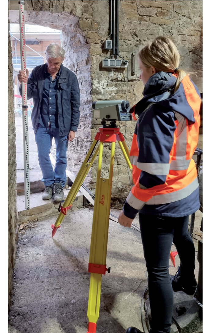
Vermessungstechnische Kontrolle und Einbau der Hammersäulen © Klaus Kaiser / Konsortium Deilbachtal
