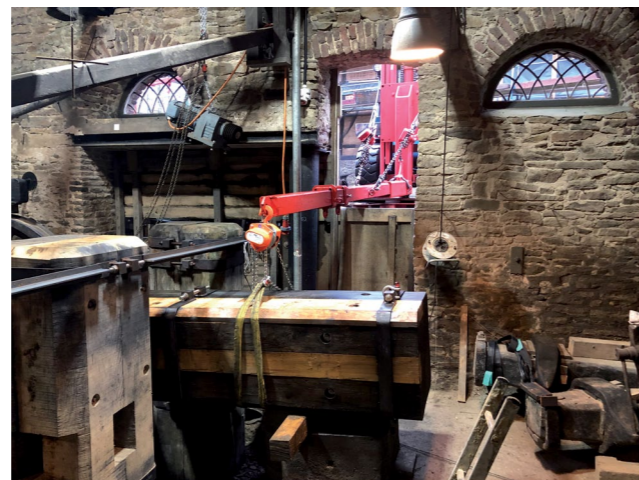
Einbringen eines Prellholzes in die Baugrube, 2022 © Achim Mikuscheit/Ruhr Museum
