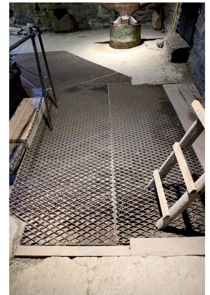
Sichtgitterabdeckungen des unterirdisch verlaufenden Unterwassergrabens der Luftwelle, 2026 © Christoph Sebastian/Ruhr Museum
