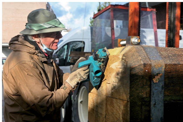
Gerdt Schraven mit Hobelarbeiten an einer der neuen Hammersäulen, 2020 © Rainer Rothenberg/Ruhr Museum
