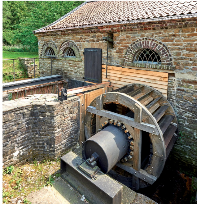
Hammergebäude mit neuem Wasserrad, neuer Wetterschutz-Verbreterung und neuer Schützenanlage, 2018 © Rainer Rothenberg/Ruhr Museum
