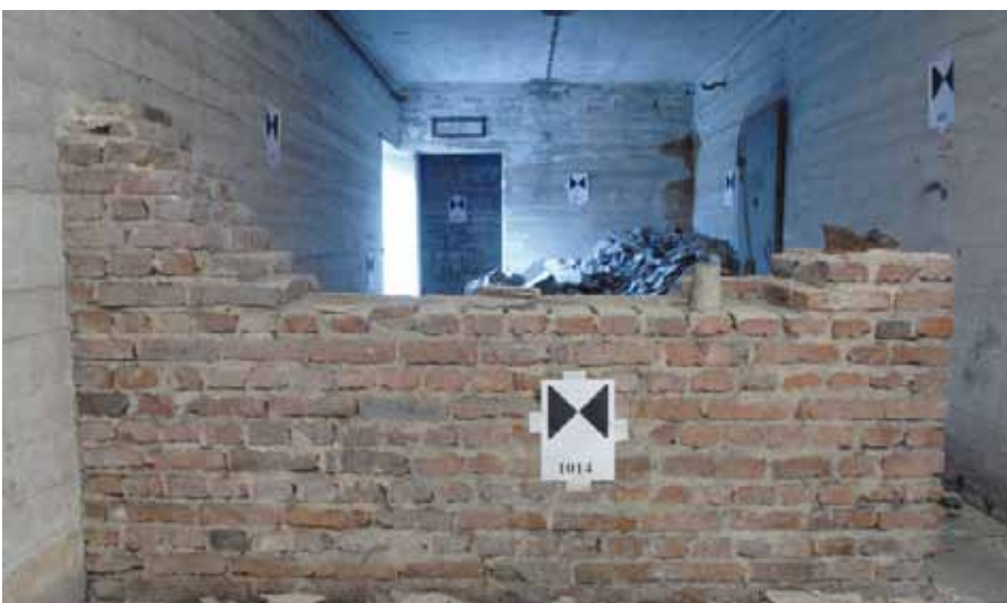
Nachträglich eingezogene Wand (Foto: D. Hopp)
