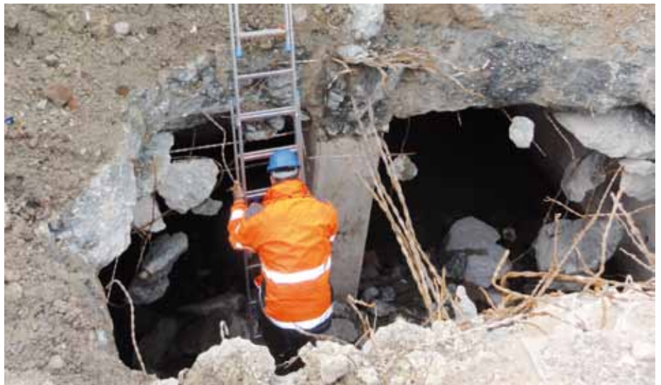
Befahrung der Anlage an der Haedenkampstraße (Foto : D. Hopp)
