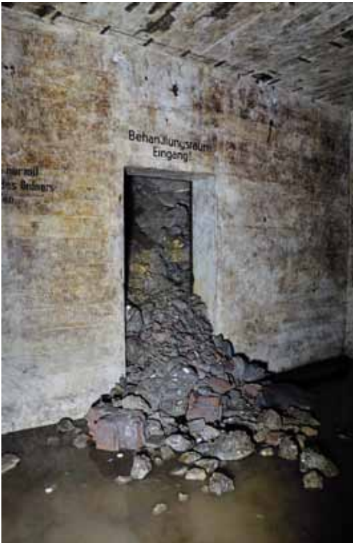
Blick in die Anlage (Foto: D. Hopp)
