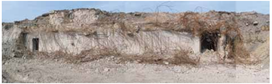
Die Anlage von außen (Fotos und Montage: D. Hopp)
