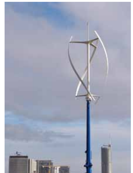
Eine Venture Capital Beteiligung von RWE Innogy macht's möglich: Zwei fünf Meter hohe Mikro-windturbinen des britischen Unternehmens Quiet Revolution erzeugen auf dem Dach des Essener Technologie- und Entwicklungs-Centrums (ETEC) Strom. ▲
