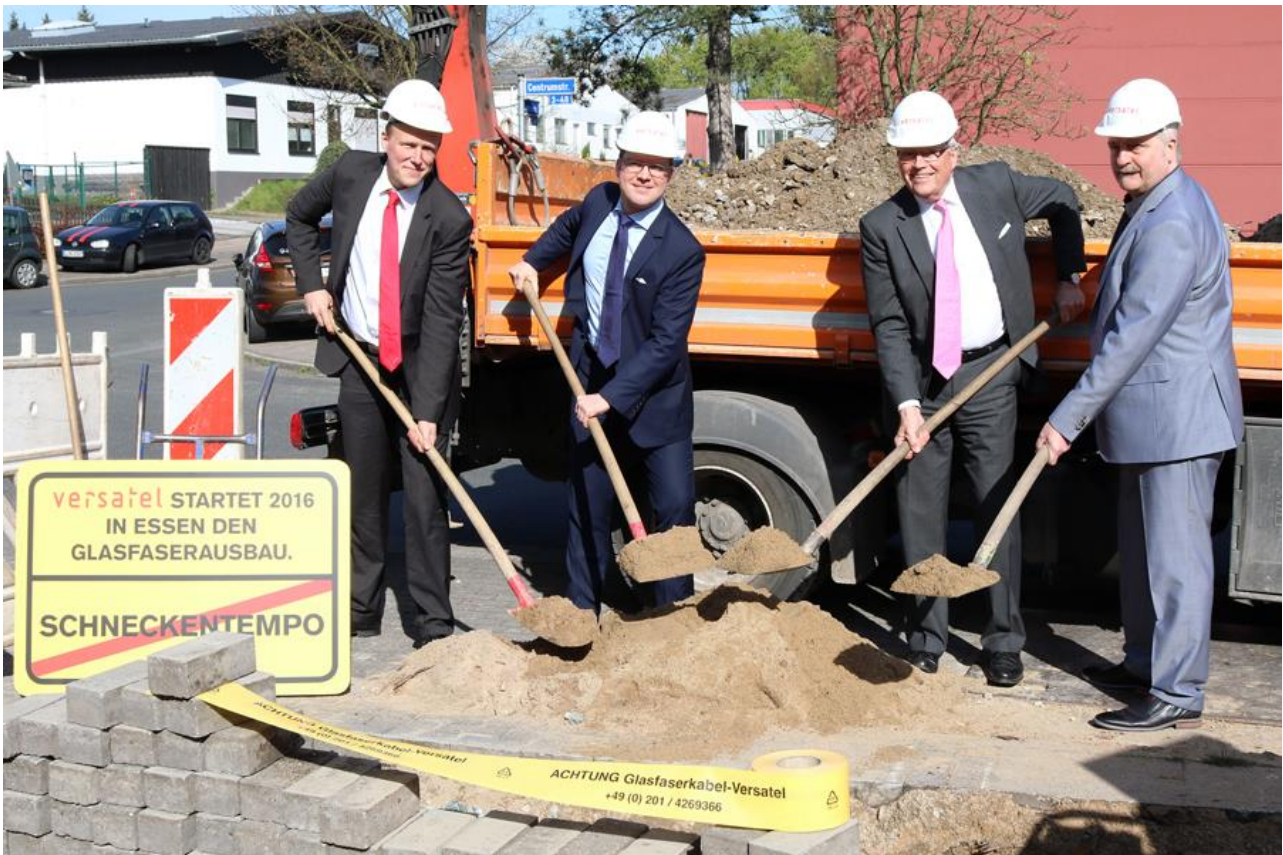
Freuen sich über den Abschluss der Tiefbauarbeiten im Gewerbegebiet Lahnbeckestraße. V.l.n.r.: Klaus Kremer und Ronny Juch von Versatel, Dr. Dietmar Düdden und Uwe Breder von der EWG. Foto: EWG
