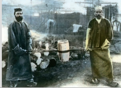
„Gießer, Tiegel von den Schmelzöfen nach der Form tragend“, vor 1902 © Historisches Archiv Krupp
